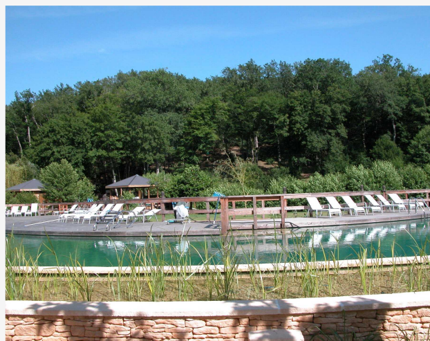
Biologické filtrační zóny jsou oddělené zdílkou.
