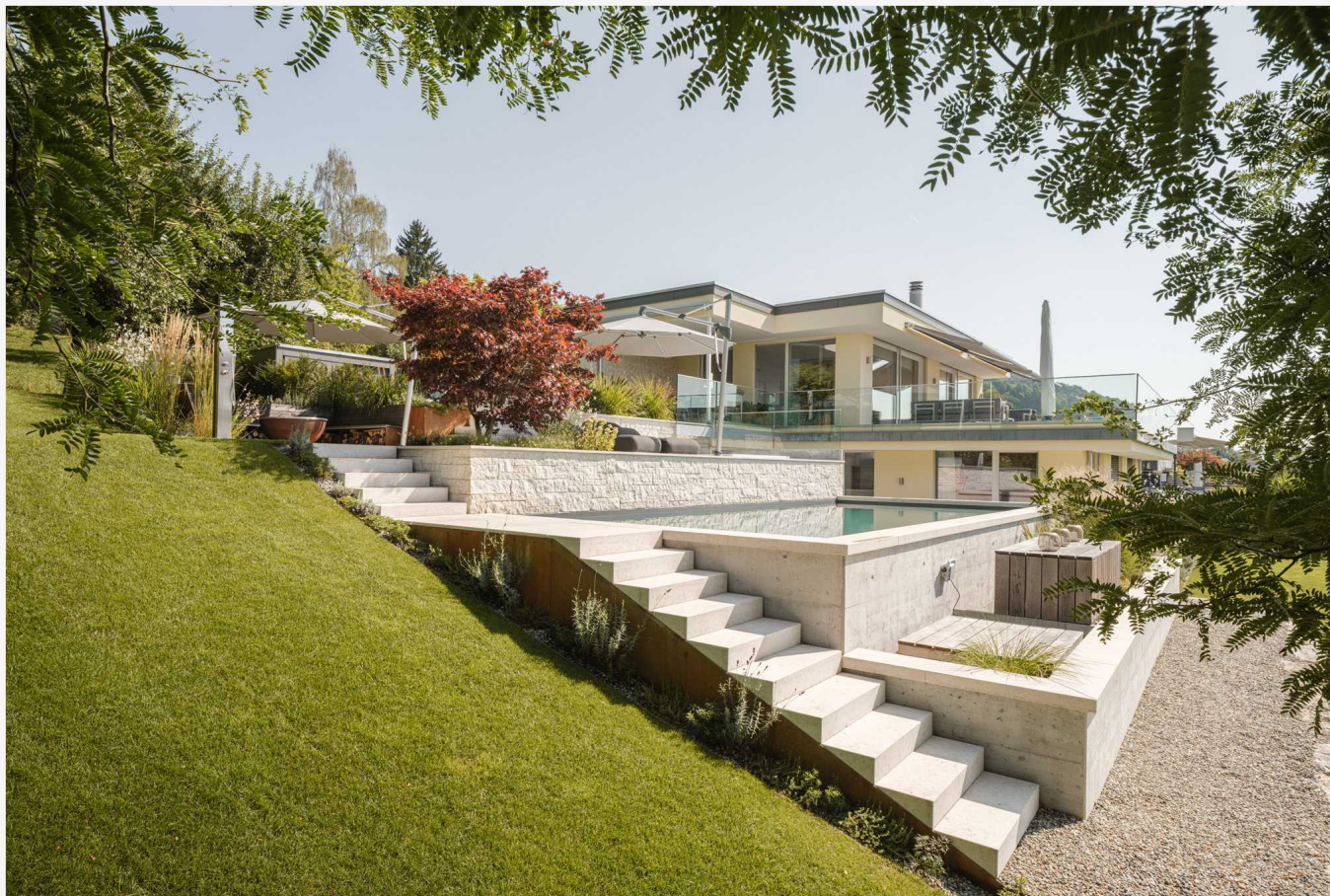
Terasovitá stavba skvěle ladí s architekturou domu elegantně využívající svažité terén.
