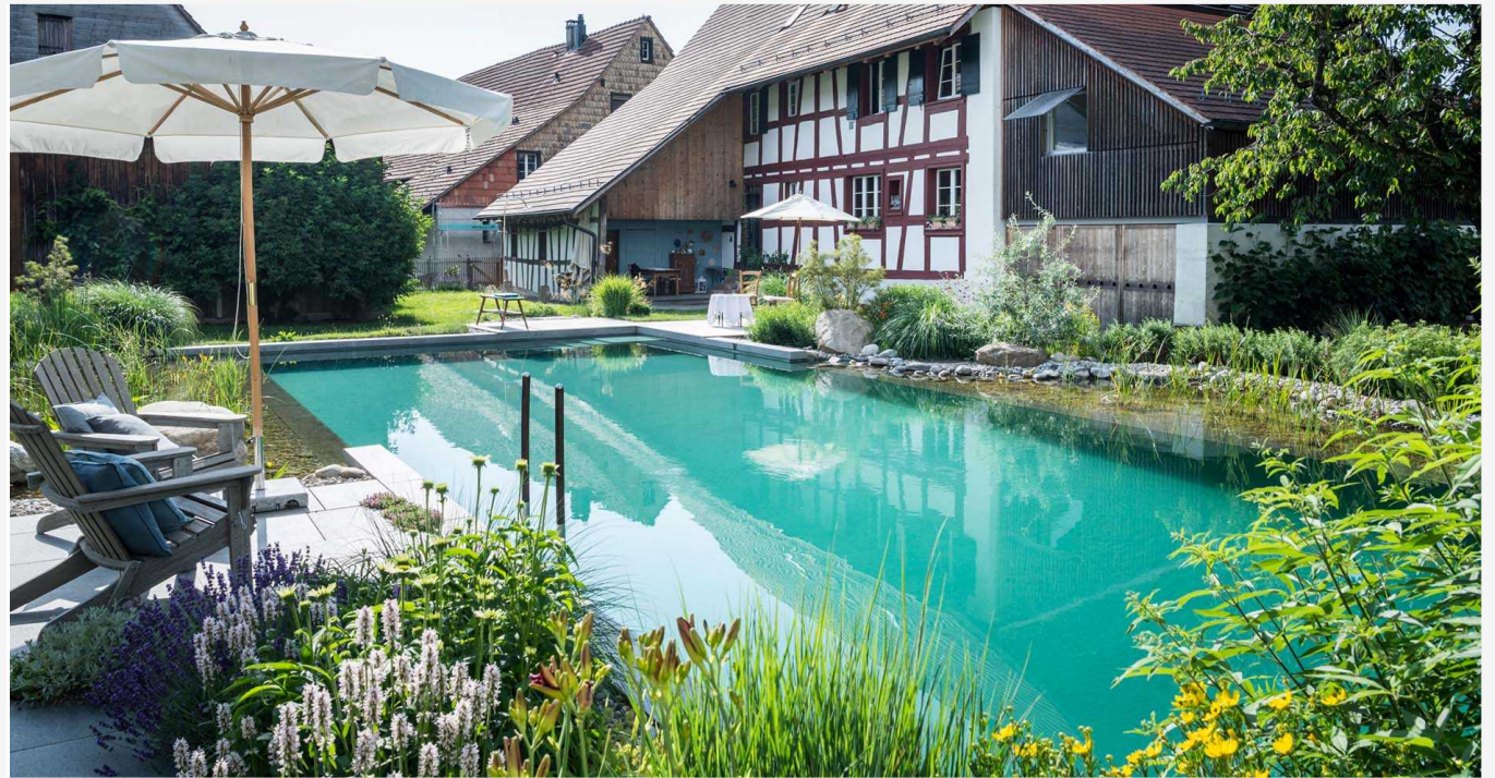
Pro bazén těchto rozměrů bylo třeba využít dvou biologických filtračních zón. Obě jsou integrované pod lagunou a osázené rostlinami.
